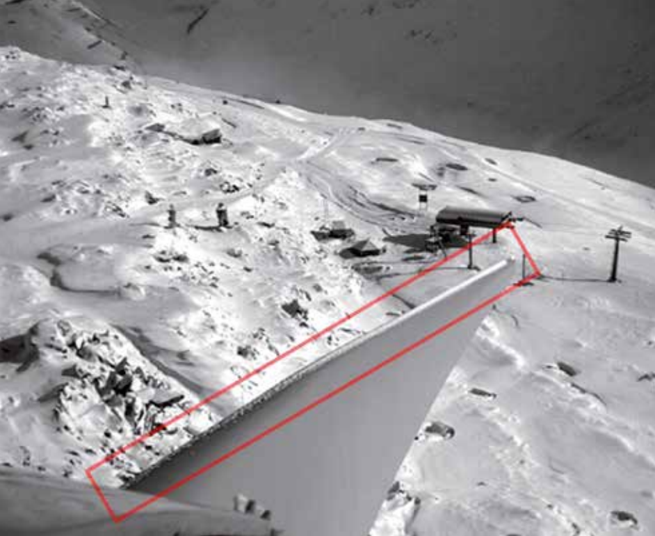
Eisansatz an der Windturbine auf dem Gütsch oberhalb Andermatt (Webcam-bild).
