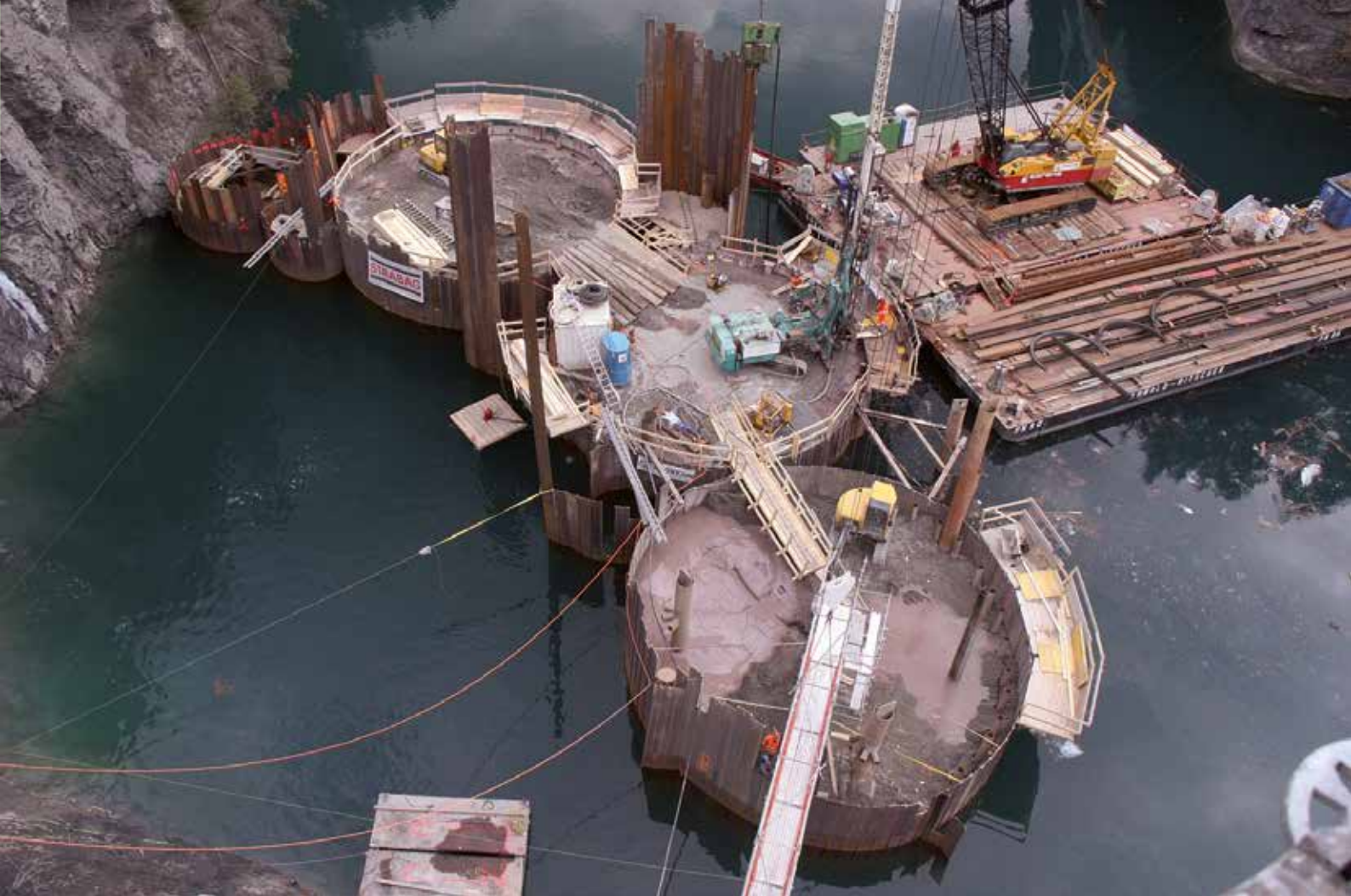
Baustelle des Geschiebeumleitstollens des Stausees Solis an der Albula in Graubünden.
